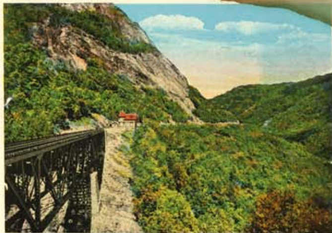
WILEY BROOK BRIDGE, WHITE MTS., N. H.
